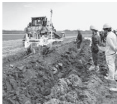
掘削土と表土を入れ替えた
