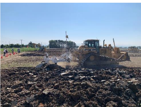
プラウ現場 見学
