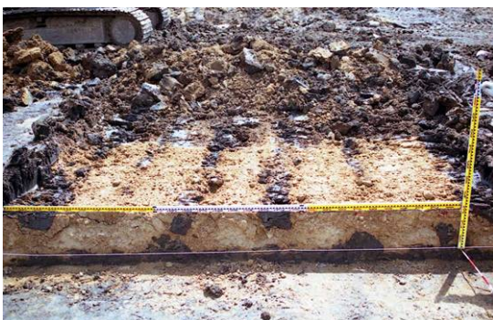
写真-18 反転後の状況(1 段耕プラウ)
